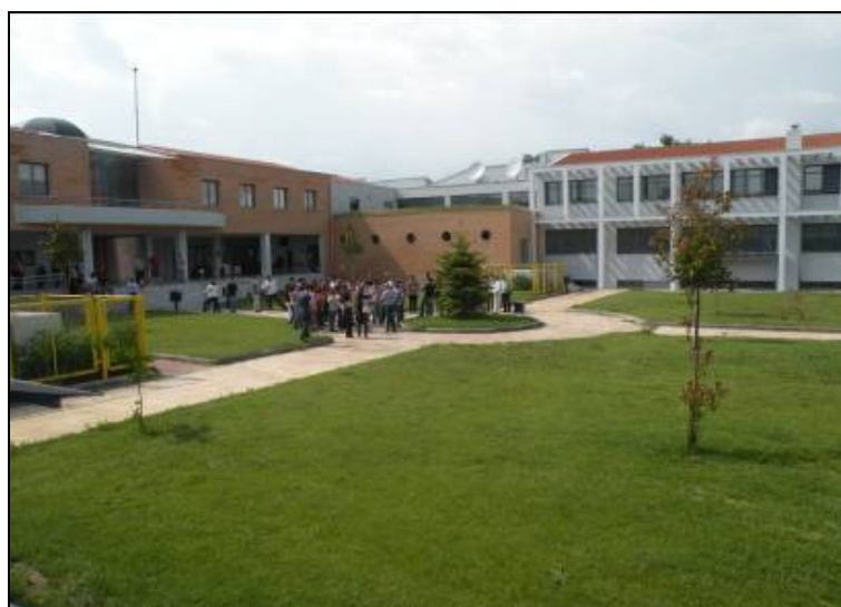
Αποψη της εσωτερική αυλής
